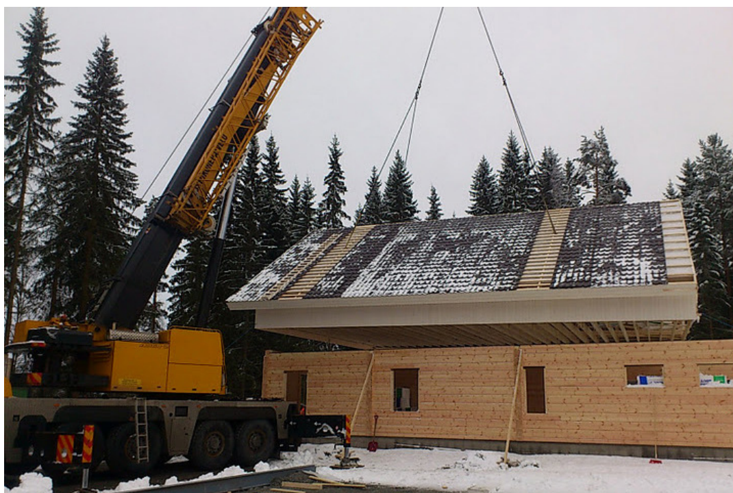
À Kuopio en Finlande, l'école maternelle en bois massif Honka en cours de construction.
