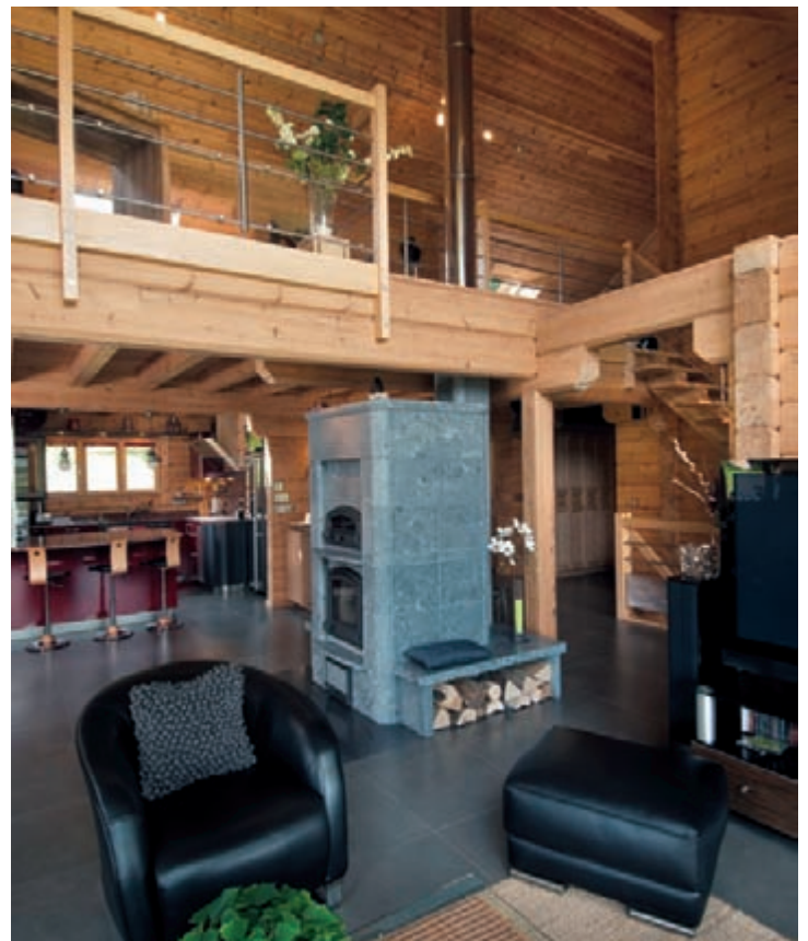
Poêle à bois à accumulation de chez Tulikivi. La pierre (stéatite) dont il est habillé permet d'accumuler la chaleur et de la restituer doucement par rayonnement tout au long de la journée. En le plaçant au cœur de la maison la diffusion de la chaleur est homogène et profite à tous les espaces.
